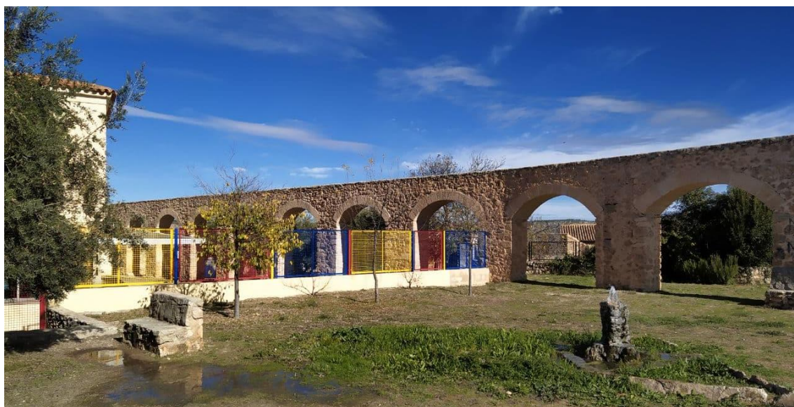
Figura 78. Acueducto de la Ermita de San Sebastián en la parcela del colegio público.
