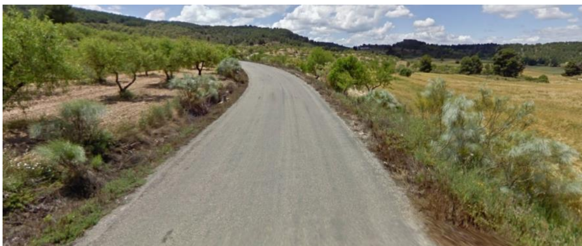
Figura 126. Carretera CM-3225 al oeste de Letur (fuente: Google maps).
