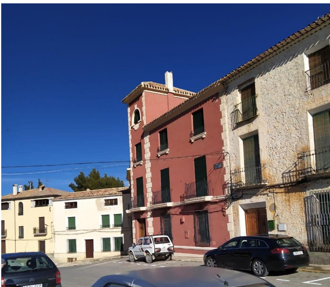
Figura 87. Antiguo edificio Cuartel de la Guardia Civil.
