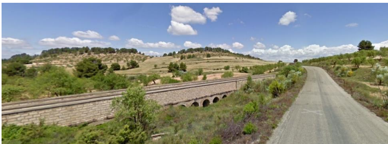
Figura 101. Acueducto en el Canal Alto de Taibilla, Letur (fuente: Google maps).
