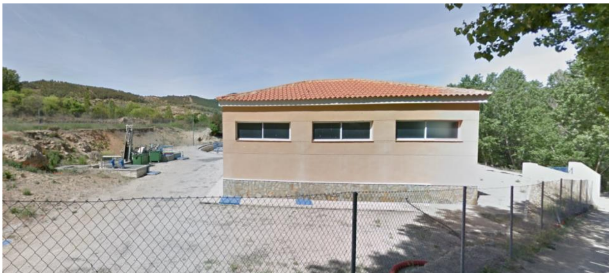
Figura 210. Estación Depuradora de Aguas Residuales de Letur.
