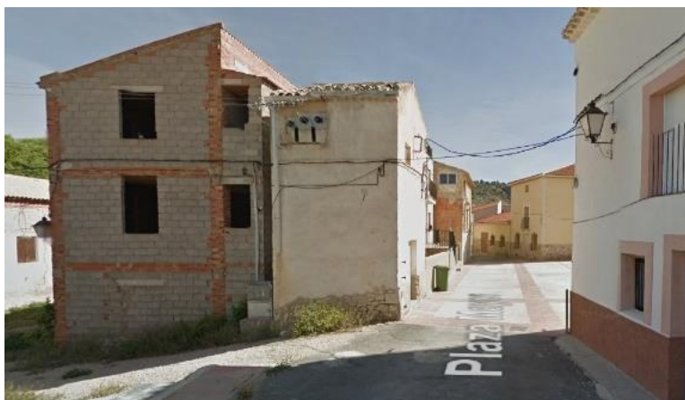
Figura 160. Centro de transformación en La Abejuela. Plaza Mayor (fuente: Google maps).
