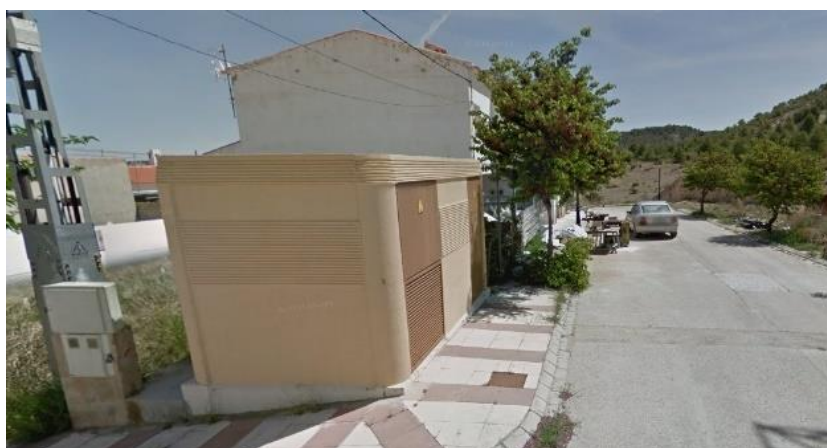
Figura 162. Centro de transformación en Letur. Calle Azucena (fuente: Google maps).
