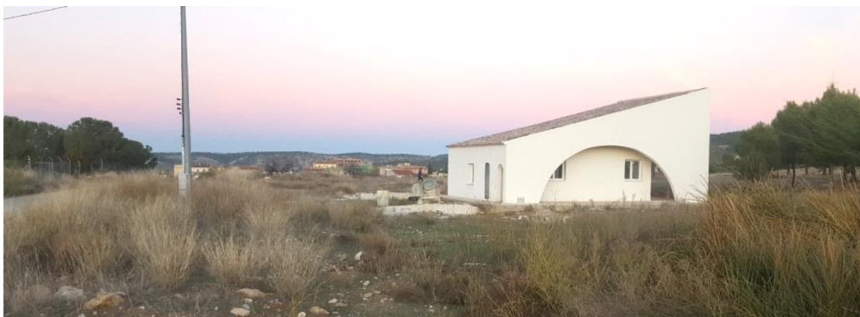
Figura 204. Velatorio municipal (Polígono Industrial Los Llanos de San Antón).
