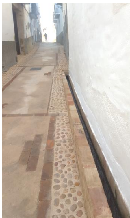
Figura 154. Acequia en superficie en Calle Mayor (Letur).
