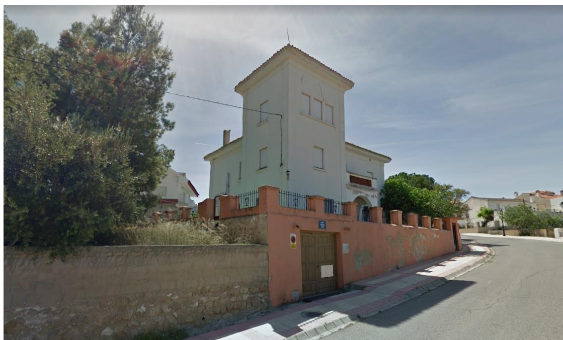
Figura 89. Edificio residencial privado en arranque Avenida Guardia Civil.
