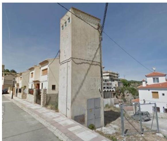
Figura 161. Centro de transformación en Letur. Calle Cantero (fuente: Google maps).
