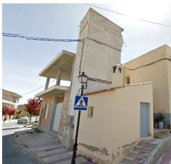
Figura 163. Centro de transformación en Letur. Calle El Puente (fuente: Google maps).
