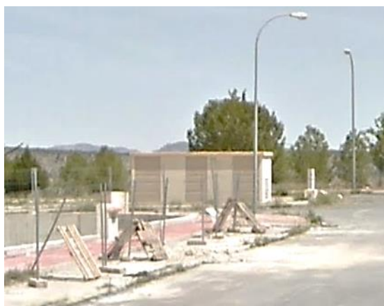
Figura 165. Centro de transformación en el polígono industrial Llanos de San Antón (fuente: Google maps).
